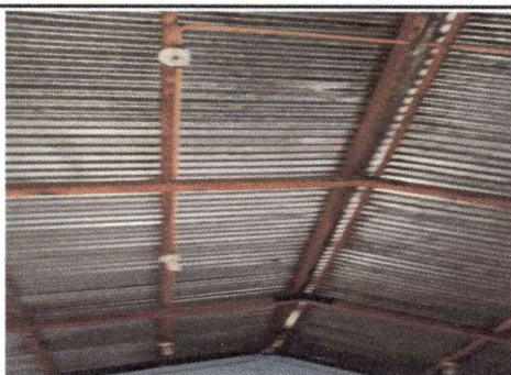
Foto 5: Sustitución de lamina por lamina troquelada aluzinc calibre 26.
