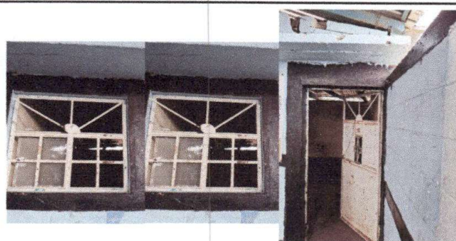
Foto 2: Mantenimiento de estructura (aplicación de pintura)
