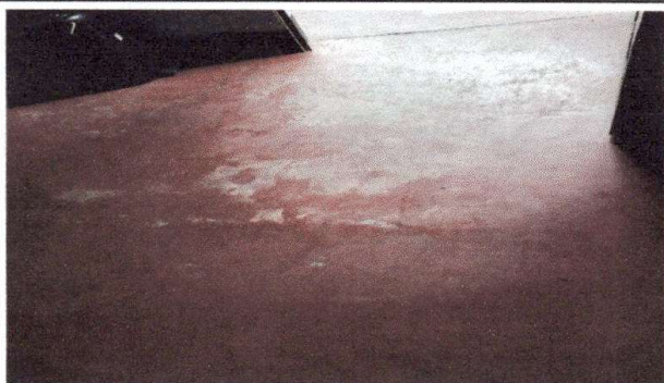
Foto 3: Reparacion de piso ceramico
