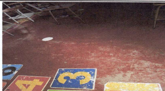
Foto 4: Reparacion de piso ceramico
