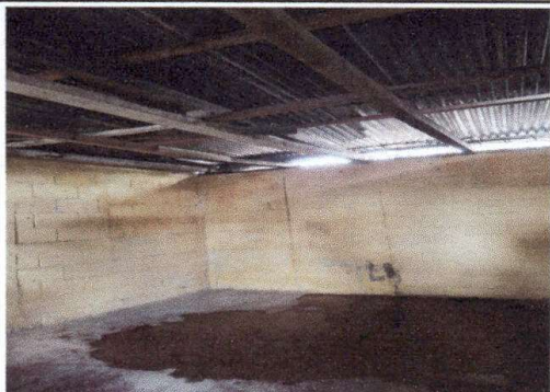
Foto1: Sustitución de estructura de soporte de madera por metal.
